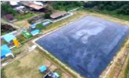
PLTBg Pagar Merbau, 1 MW
