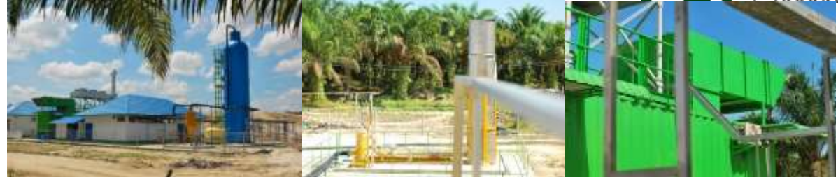
Pembangunan PLT Biogas Desa Rantau Sakti, Rokan Hulu (2013)
